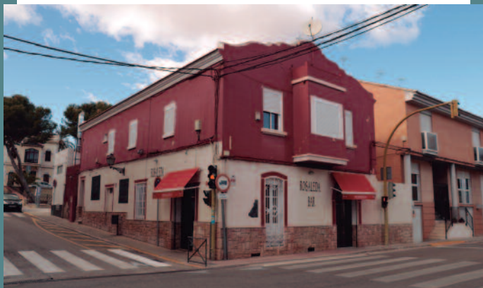
Estado actual del Rosaleda
