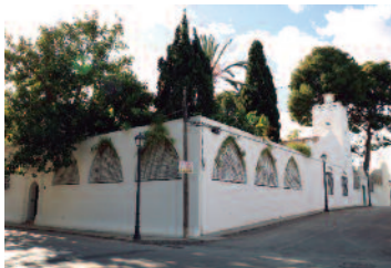
Estado actual de la vivienda
